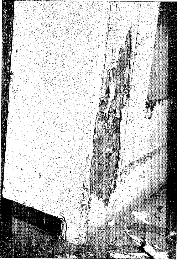
Dégâts de Coptotermes testaceus à l'intérieur d'une habitation.
