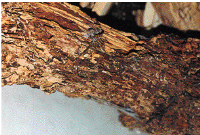
Photo 8. Poutre détruite par Heterotermes tenuis (Guyane). Beam destroyed by Heterotermes tenuis (French Guiana).
